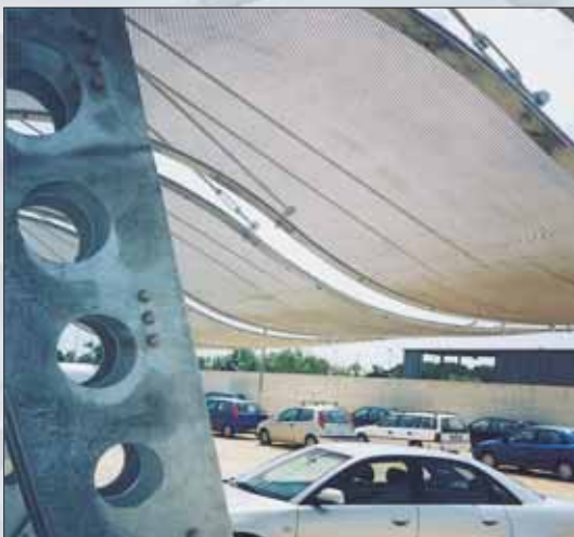
FILS 20 - DL 45 x DC 15 (11,4) - av 3,3 x sp 2 mm Edelstahl AISI 304 - Werkstoff 1.4301
